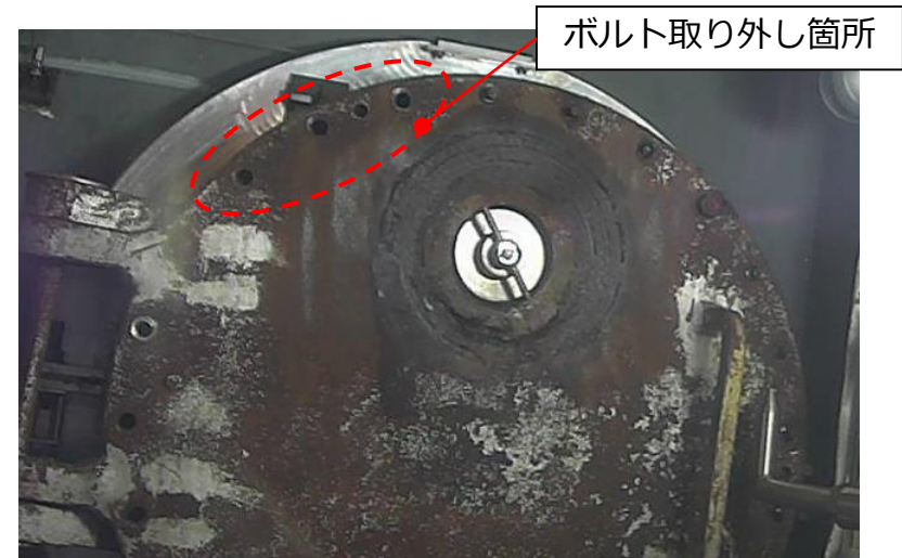
ボルト取り外し後
