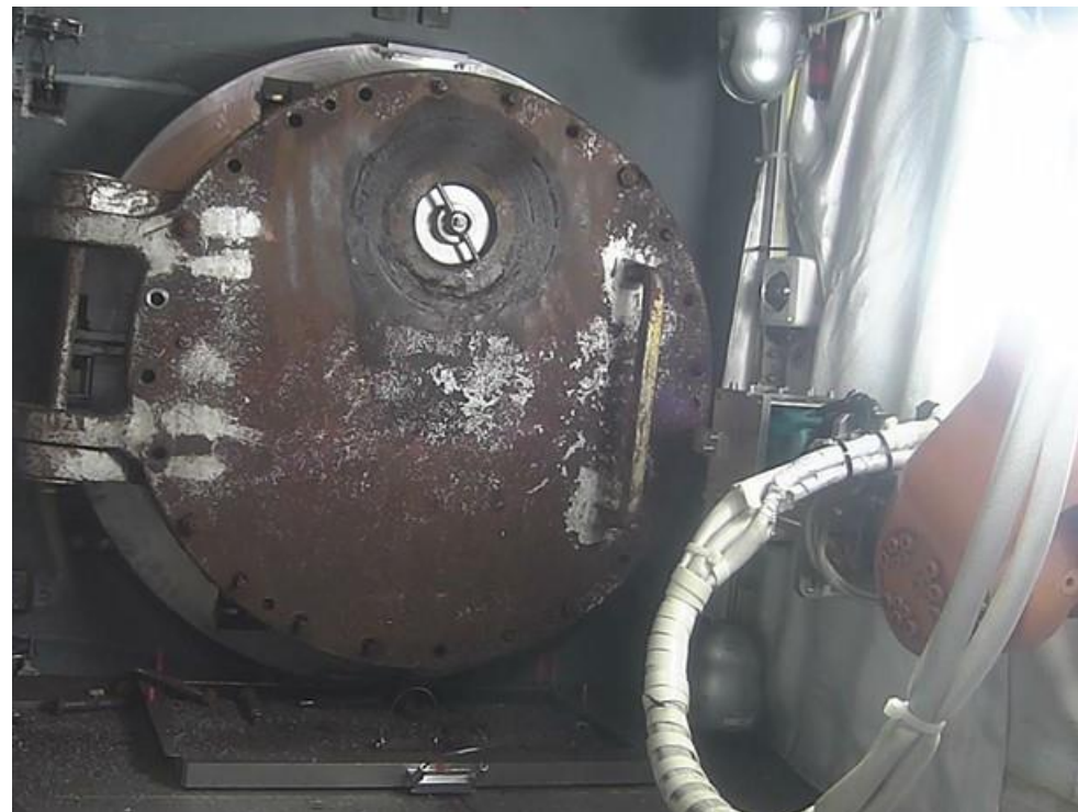
ボルト除去作業状況
