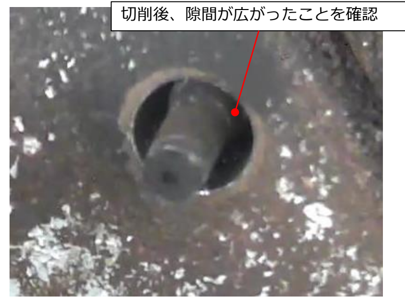
長尺ホールソー切削作業状況
