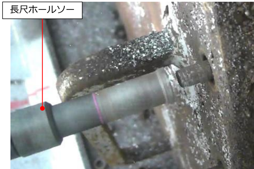
長尺ホールソー切削作業状況
