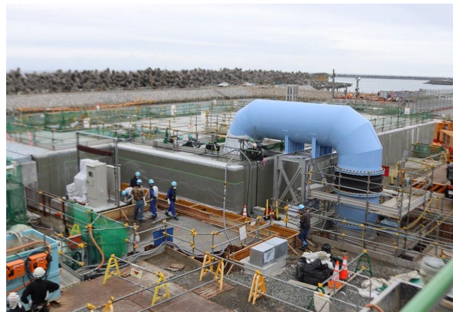
放水立坑（上流水槽）全景 [2023年6月23日撮影]
