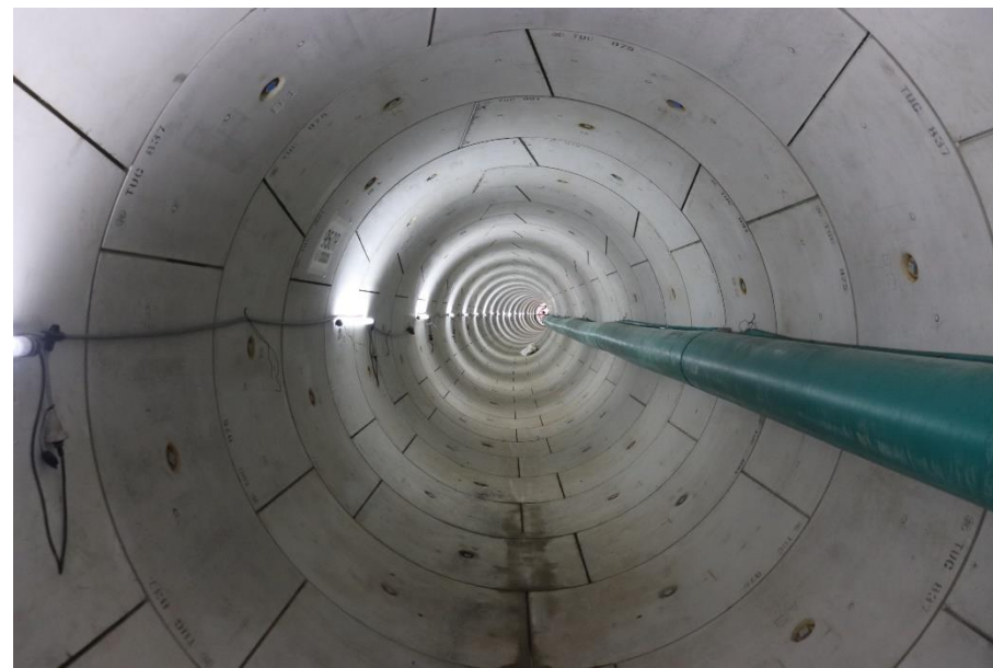
掘進完了後の放水トンネル内 〔2023年5月23日撮影〕 (照明および送気ダクトは注水時に撤去)
