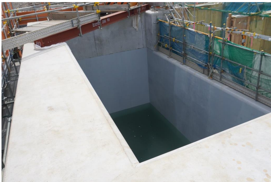
水張り完了後の放水立坑（下流水槽） 〔2023年6月6日撮影〕
