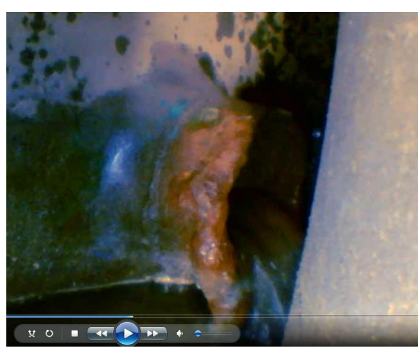
散水によるピット水位上昇の状況（左：ピット内部、右：流入配管近傍）
