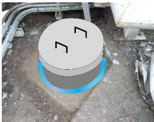
②発泡ウレタンをマンホールの隙間に充填
