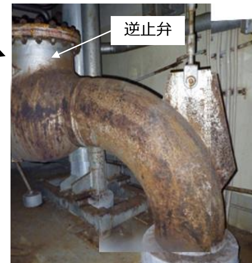
既設CUW配管
