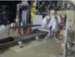
＜貫通孔前での作業状況＞
