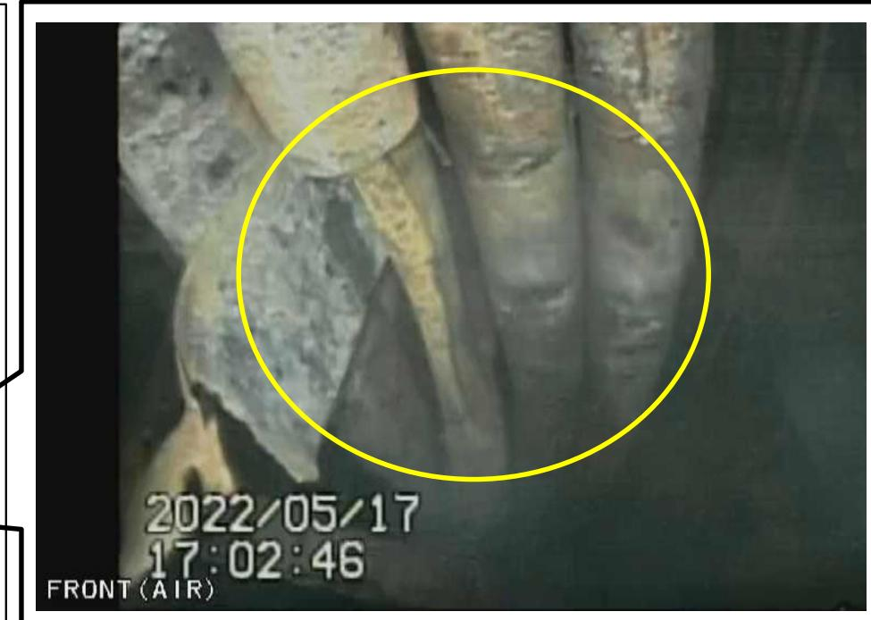
写真2. D/W内配管の状況
