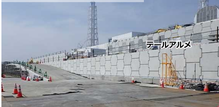
テールアルメ設置状況
