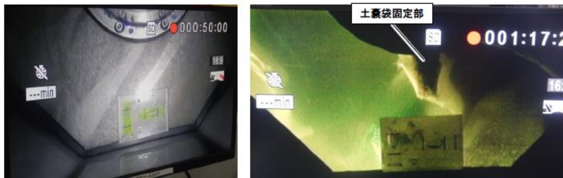
回収ツールでの土嚢袋の視認状況
