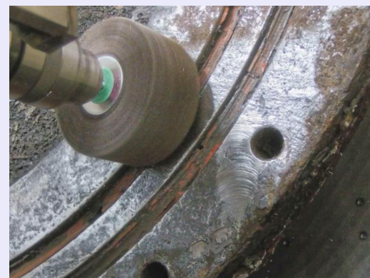
＜X-6ペネ フランジ面の清掃の様子＞
