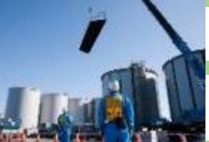
溶接タンク建設中の様子
