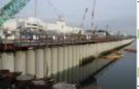
海側遮水壁打設完了の様子
