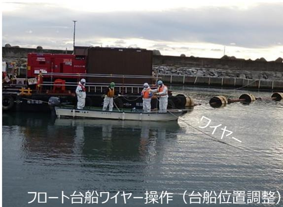
フロート台船ワイヤー操作 (台船位置調整)
