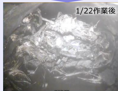
＜低圧水による堆積物除去の様子＞
