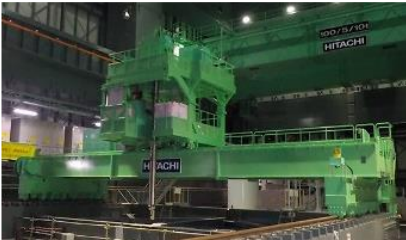
有効活用する4号機燃料取扱機
