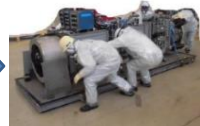
堆積物除去装置 （低圧水）撤去
