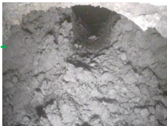
低圧水施工前 1月17日作業開始前
