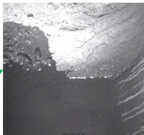
低圧水施工前 1月17日作業開始前
