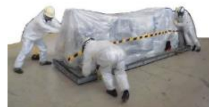
堆積物除去装置 （高圧水、AWJ）撤去
