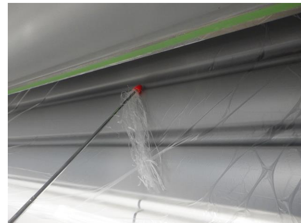
目張り実施中
