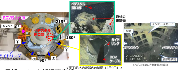
1号機 PCV内部調査実績
