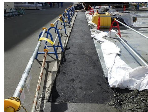
エリア②アスファルト舗装完了 (2/27)
