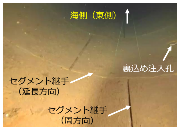
トンネル底面の状況
