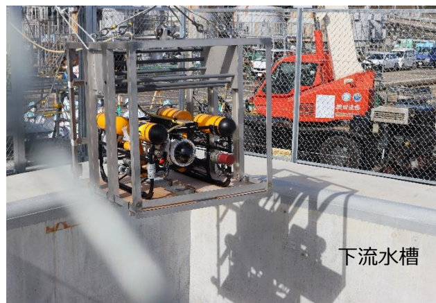
水中ROV投入状況
