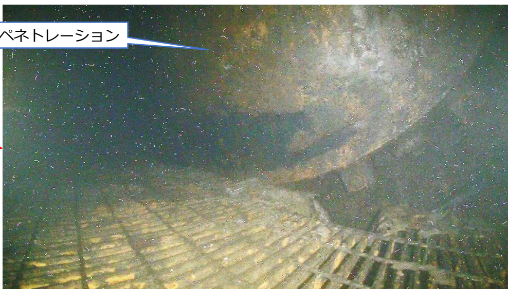
写真1.X-1ペネトレーションの状況
