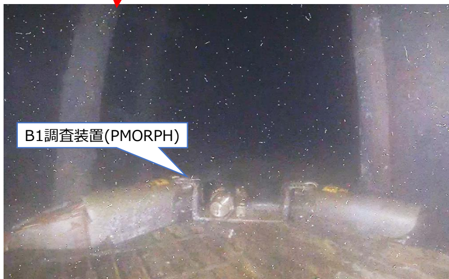
写真2.南側B1調査装置(PMORPH)の残置状況
