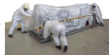
堆積物除去装置 (高圧水、AWJ) 撤去
