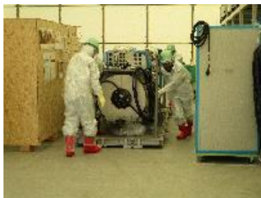
堆積物除去装置 (高圧水、AWJ) 設置
