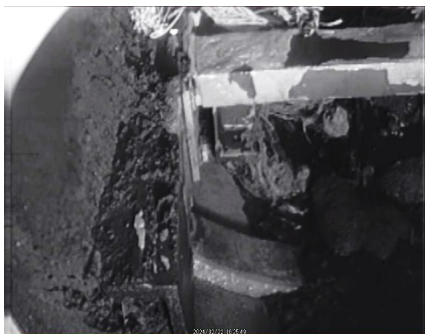
高圧水施工後 (X-6ペネ左下部)
