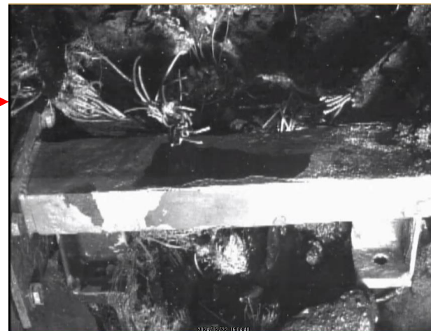
高圧水施工後 (X-6ペネ中央部)
