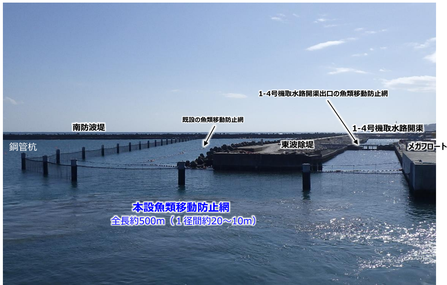
図2.東波除堤魚類移動防止網リプレイス工事の網設置状況（2024年2月17日撮影）
