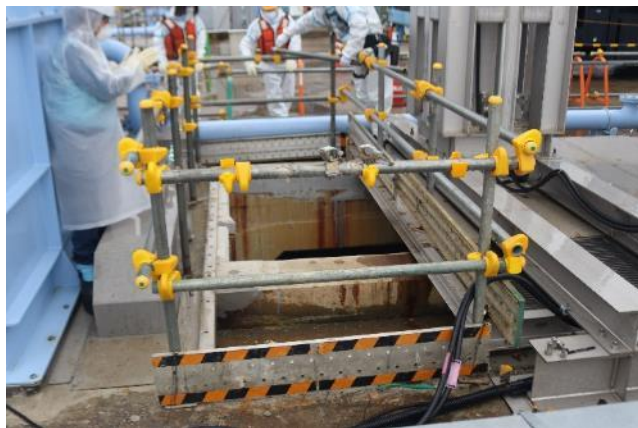
取水モニタ南側の開口養生
