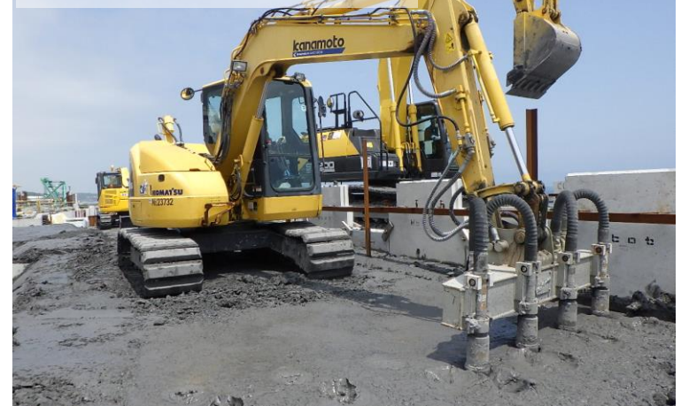
アッシュクリート打設状況
