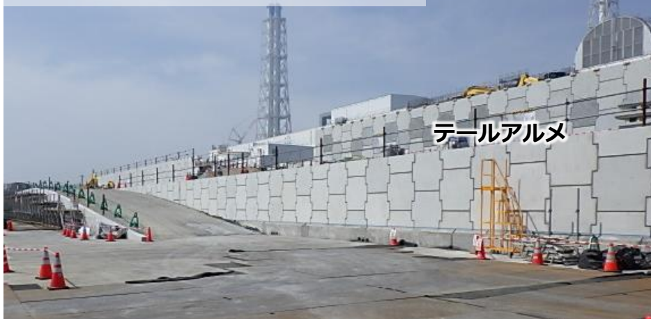
テールアルメ設置状況
