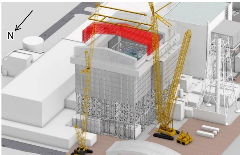
可動屋根設置中
