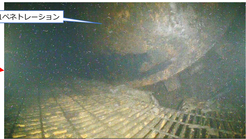
写真1.X-1ペネトレーションの状況
