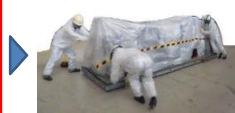
堆積物除去装置 (高圧水、AWJ) 撤去
