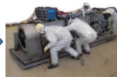
堆積物除去装置 (低圧水) 撤去
