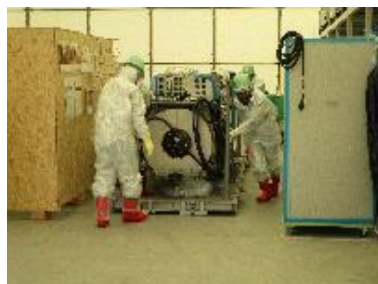
堆積物除去装置 (高圧水、AWJ) 設置
