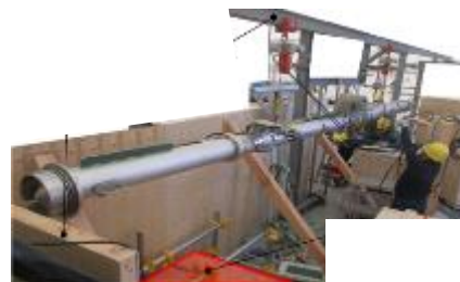
スプレイ治具設置 ※X-53ペネに接続
