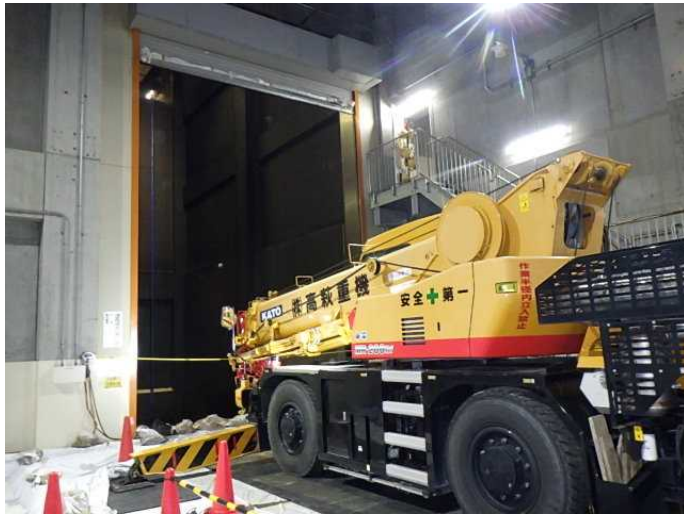
ラフタークレーン配置
