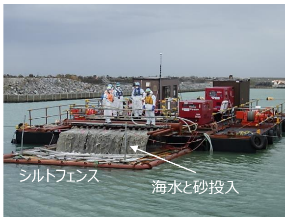
図10.ユニフロート台船による1層目の覆砂投入状況
