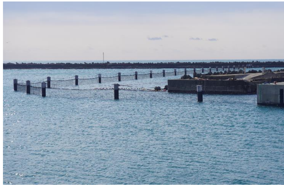
図2-2.1-4号機取水路開渠周辺(出口)を囲う状況
