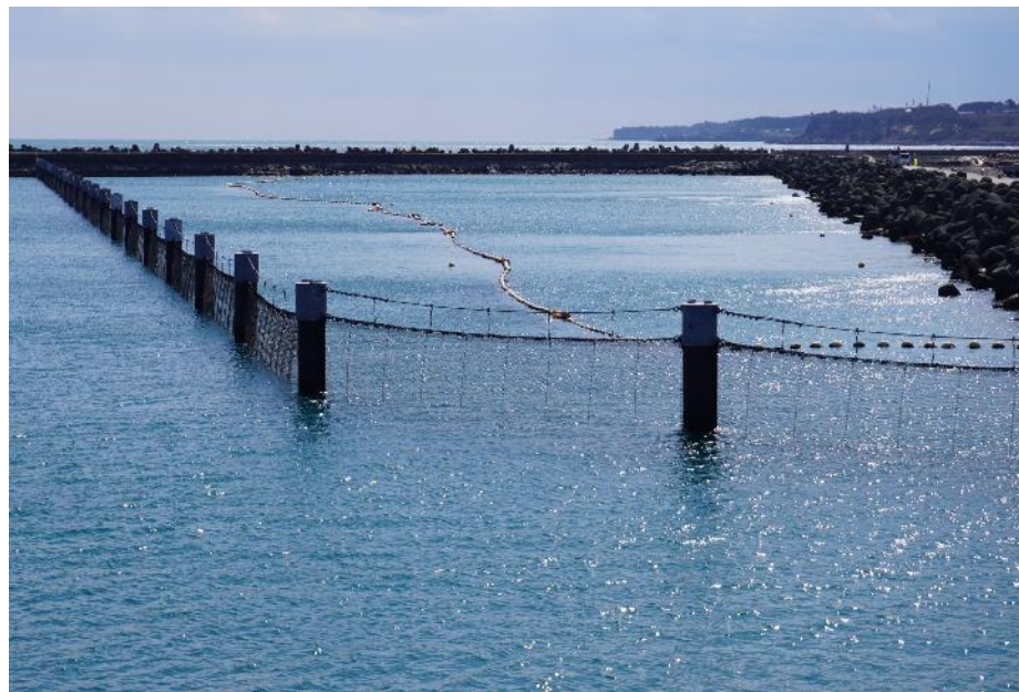
図2-1.東波除堤および1-4号機取水路開渠周辺を囲う状況
