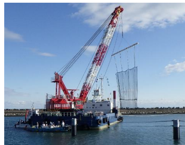
図5.作業船で高耐久網を設置している状況 (2024年1月10日撮影)
