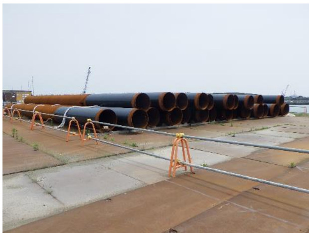
図3.使用した鋼管杭(構内での仮置き状況) (2023年6月8日撮影)
