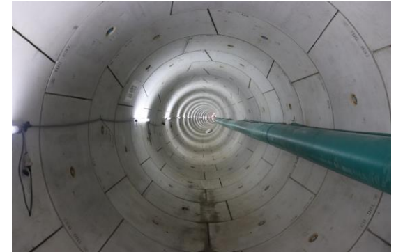
掘進完了後の放水トンネル内（2023年5月）
