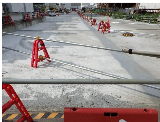
③コンクリート打設完了（2023.7）
