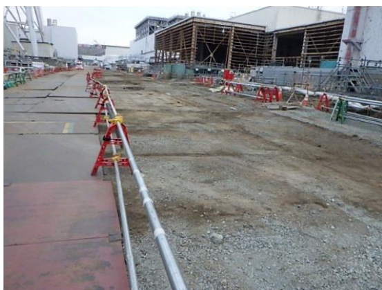
②敷き鉄板撤去、砕石敷き均し（2023.4）
