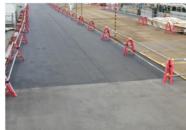
④アスファルト舗装完了（2023.9）
