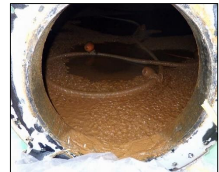
側板マンホールから内部撮影
