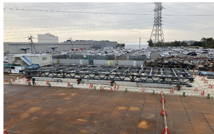
屋根鉄骨地組状況[構外]（撮影2024.4.17）
