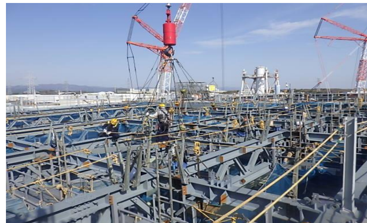
屋根鉄骨設置状況（撮影2024.4.2）
