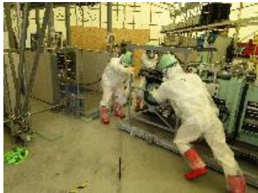
堆積物除去装置 (低圧水) 設置
