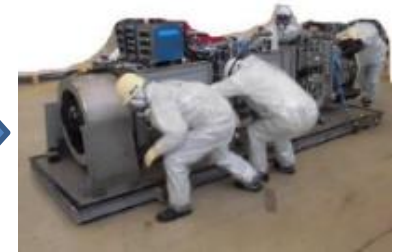
堆積物除去装置 (低圧水) 撤去
