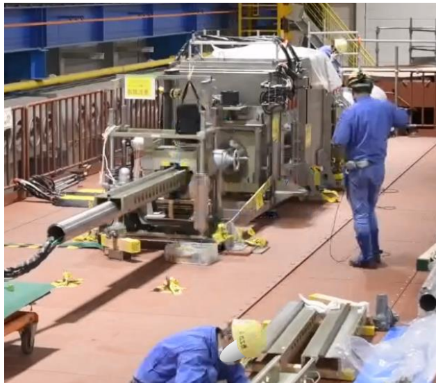
ガイドパイプの挿入
