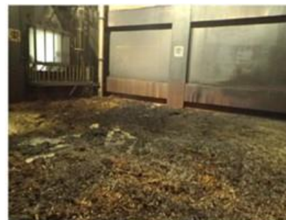
3/7撮影 廃棄物貯留ピット内の状況
