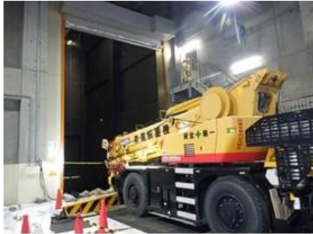
ラフタークレーン配置
