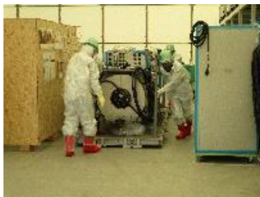
堆積物除去装置 (高圧水、AWJ) 設置
