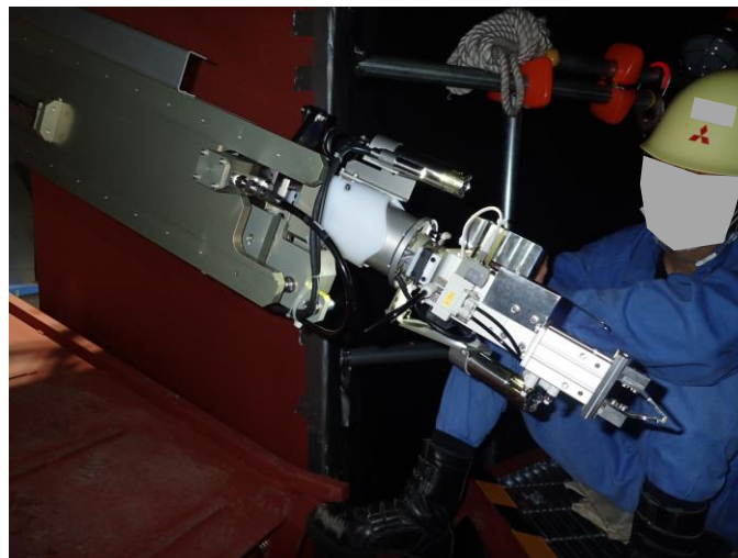
ペDESTアル内への先端治具の挿入
