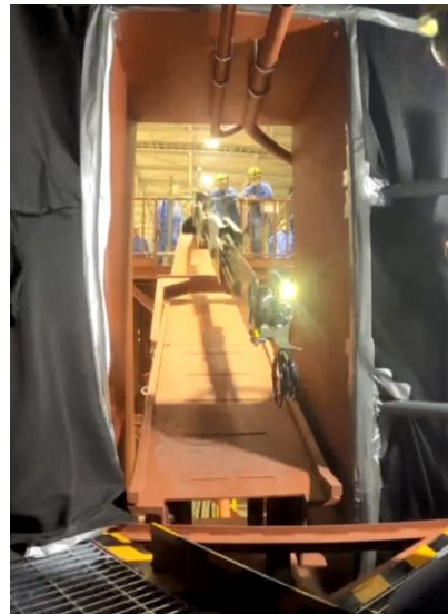
ペDESTル開口部への 装置挿入
