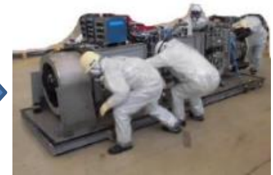
堆積物除去装置 (低圧水) 撤去
