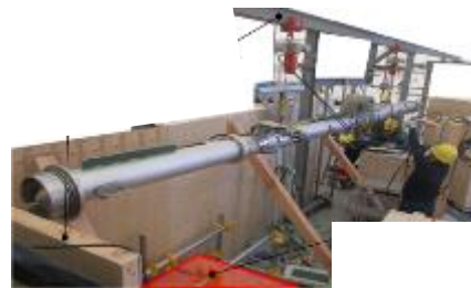
スプレー治具設置 ※X-53ペネに接続
