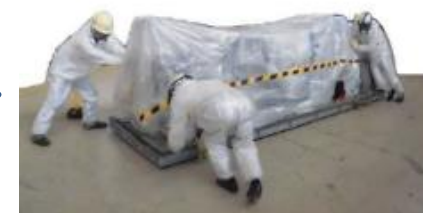
堆積物除去装置 (高圧水、AWJ) 撤去
