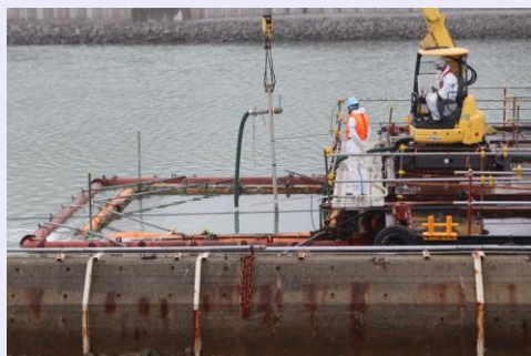
＜海底再被覆工事(覆土施工)の様子＞
