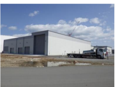
減容処理設備
