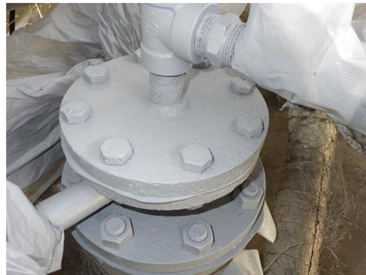
防錆塗装後の凍結管
