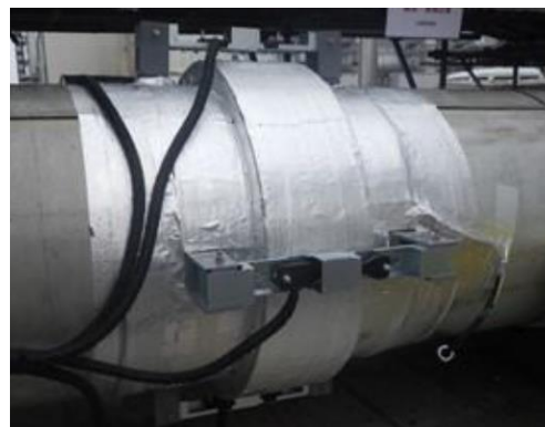
取付状況：現地モックアップ
