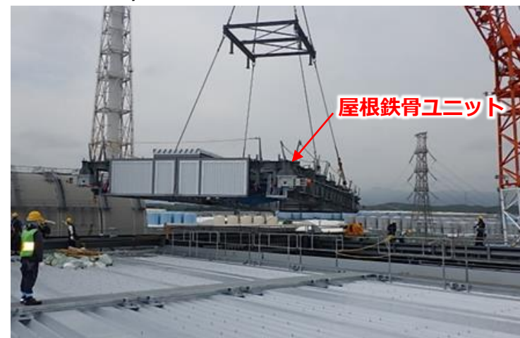
屋根鉄骨ユニット設置状況（撮影2024.6.7）
