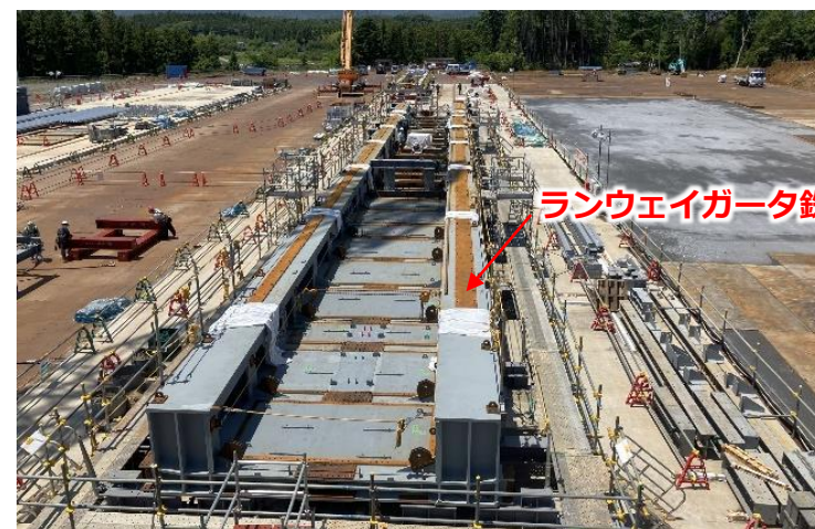
ランウェイガータ鉄骨地組状況[構外] （撮影2024.6.8）
