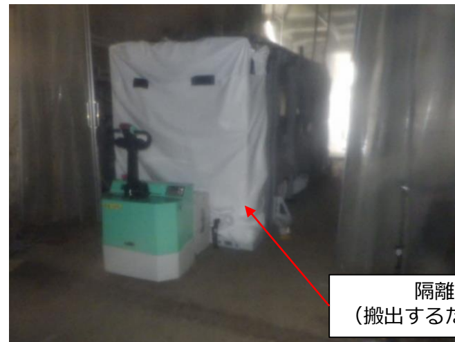
隔離部屋③を大物搬入口に運搬
