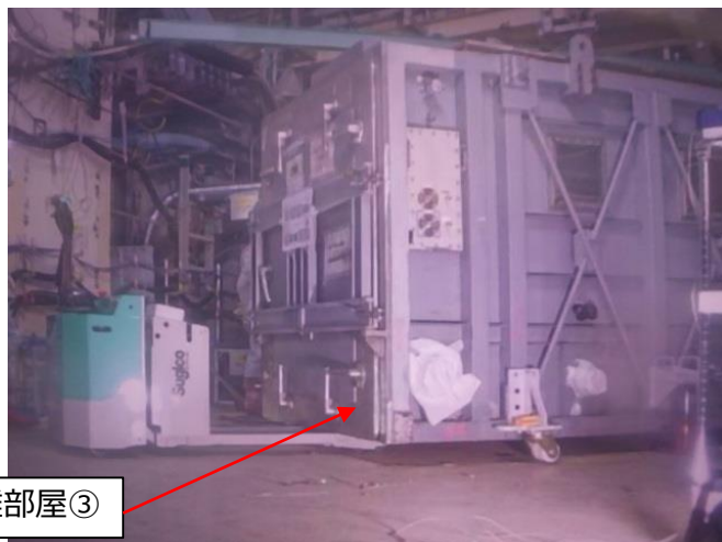
隔離部屋③を取り外し作業
