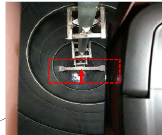
筒身内部鉄骨材（上から視点）
