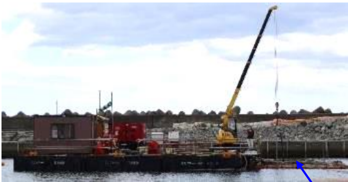
図5.ユニフロート台船による 2層目の覆土投入状況
