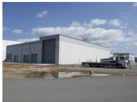
減容処理設備 現場写真
