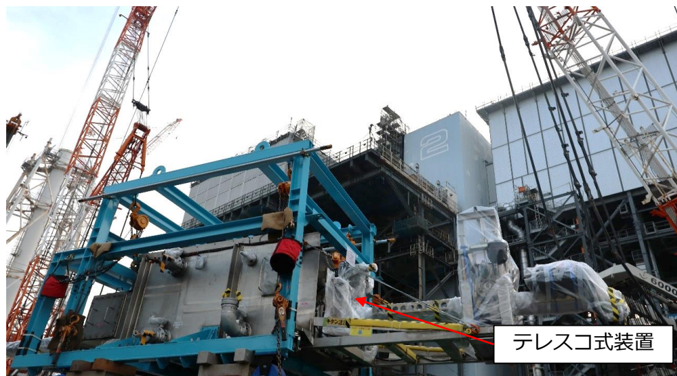
7/19 原子炉建屋内への搬入状況
