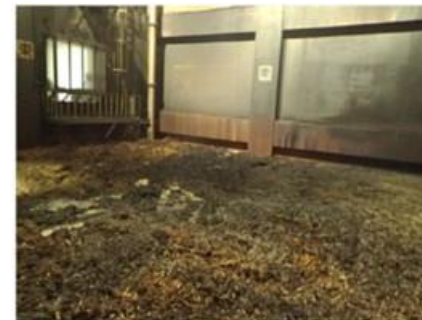
3/7撮影 廃棄物貯留ピット内の状況
