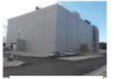
雑固体廃棄物焼却設備
