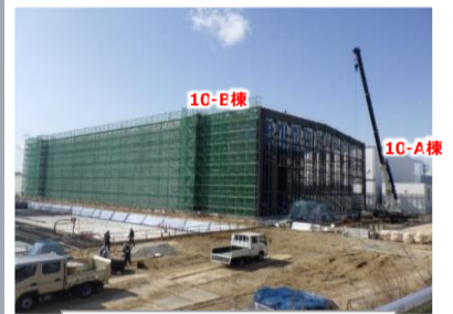
固体廃棄物貯蔵庫第10棟
