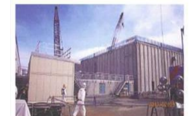
廃スラッジ一時保管施設
