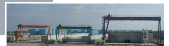
使用済吸着塔一時保管施設
