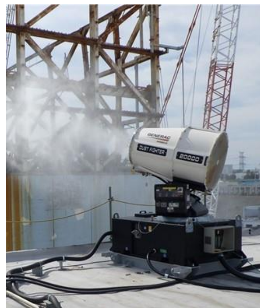
噴霧装置による散水状況
