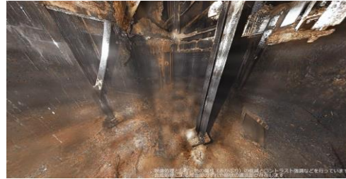
ベデスタル底部の状況（パノラマ合成処理後）
