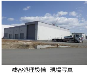
減容処理設備 現場写真
