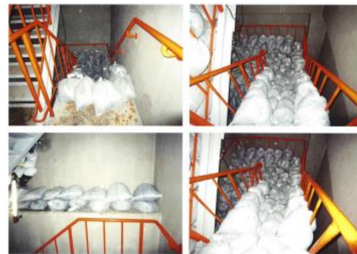
(写真：HTI 地下1階 階段室)
