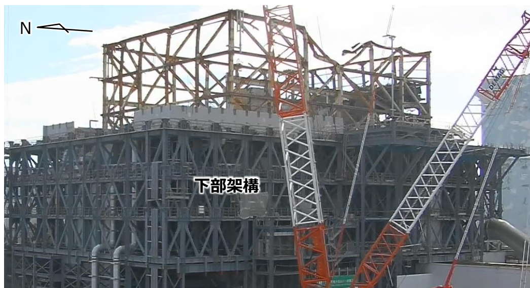
現場状況（北西面） （撮影：10月29日）
