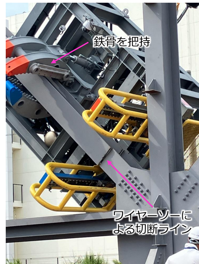
ブレース切断状況(アップ) (撮影:8月22日)
