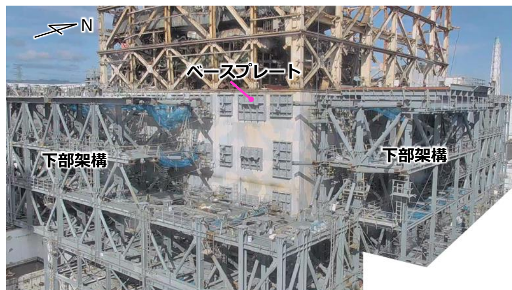
現場状況（南東面） （撮影：10月29日）
